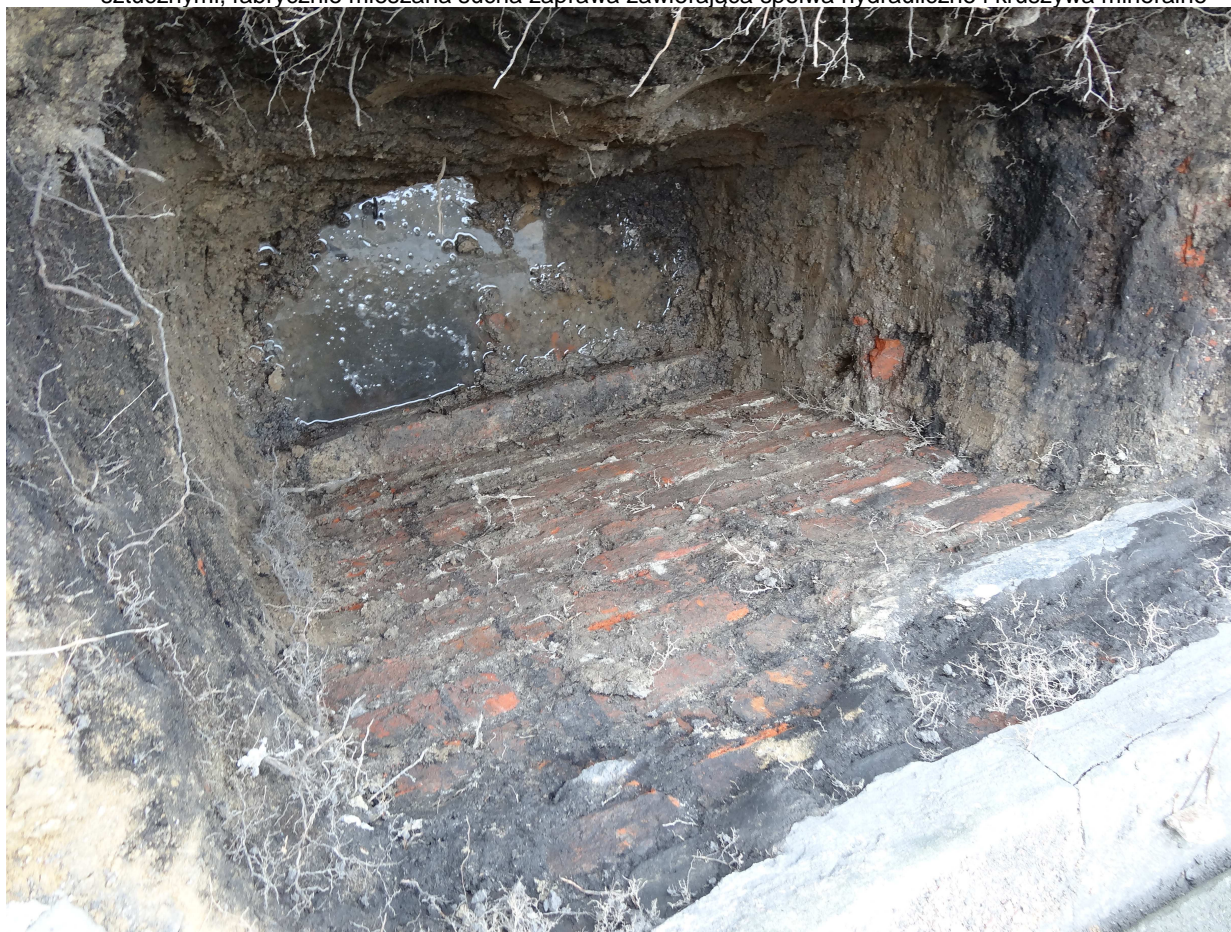
Odkrywka ścian fundamentowych od strony północnej bud. sali gimnastycznej
