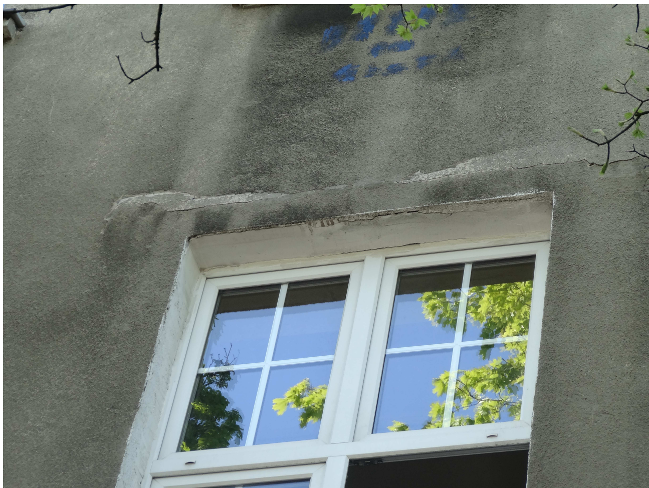
Odspojony tynk w pasie nadprożowym
