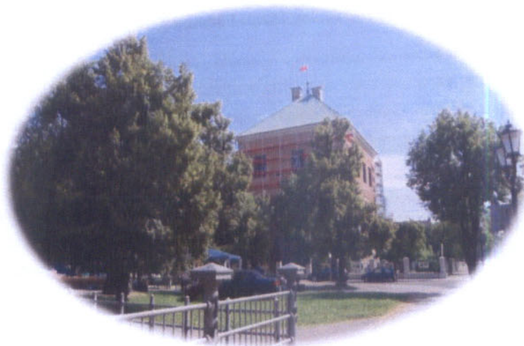
Renowacja zamku w ramach drugiego etapu projektu „Trakt Wielu Kultur”
