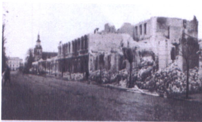
„Krzywdą” – zburzone kamienice na ulicy Słowackiego po nalocie Luftwaffe
