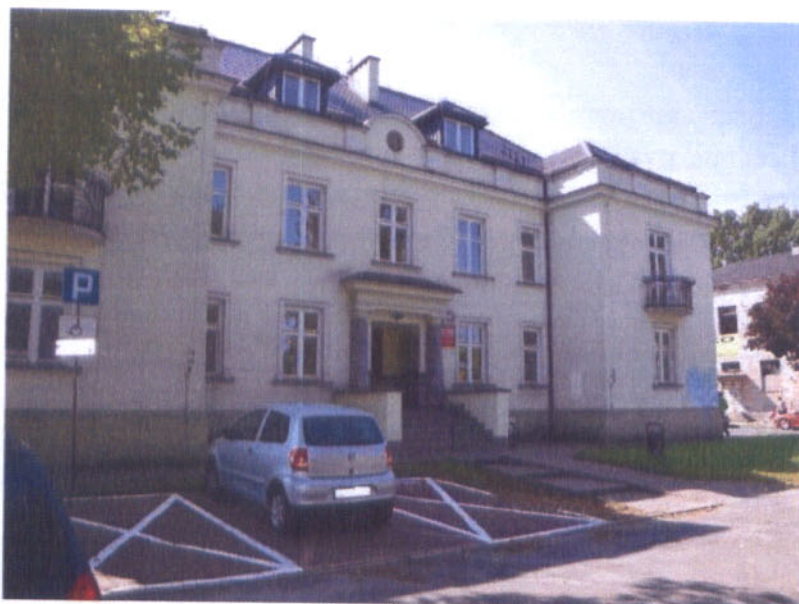
Remontowany zabytkowy budynek Miejskiego Ośrodka Pomocy Rodzinie
