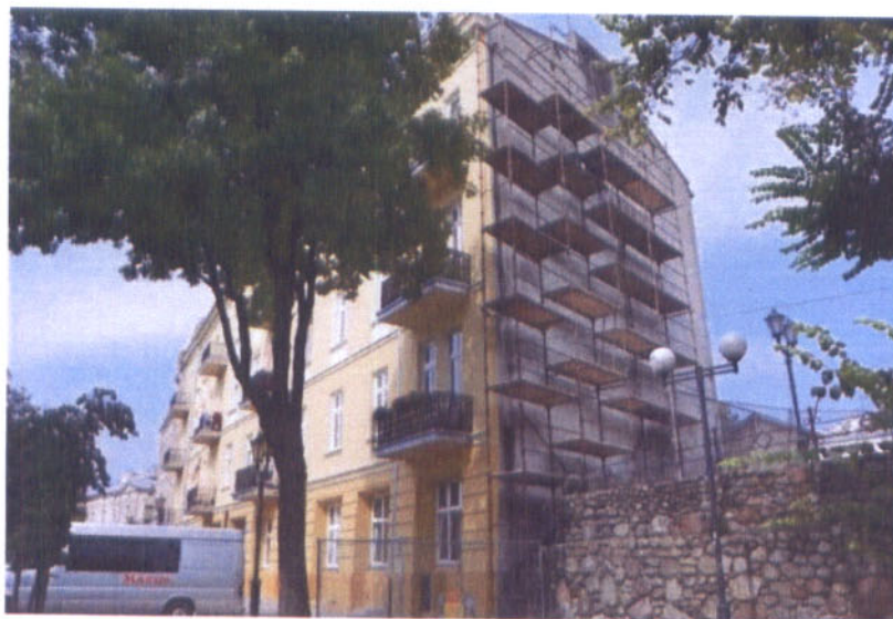
Remontowana kamienicy przy placu Niepodległości 4
