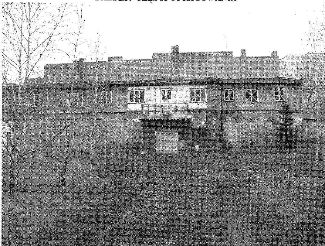
Budynek numer 6 - mieszkalny – do rozbiórki
