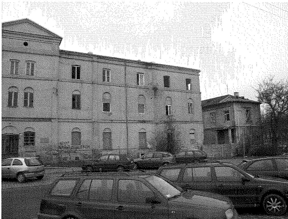
Budynek nr 1 – do rozbiórki
