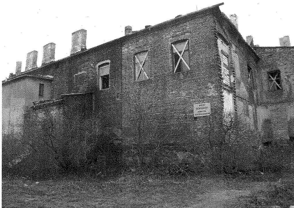
Budynek 2 – do rozbiórki
