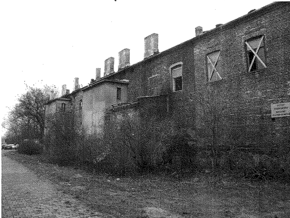
Budynek 2 – do rozbioru
