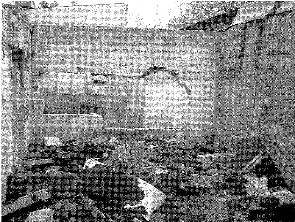
Ściany działowe budynku gospodarczego
