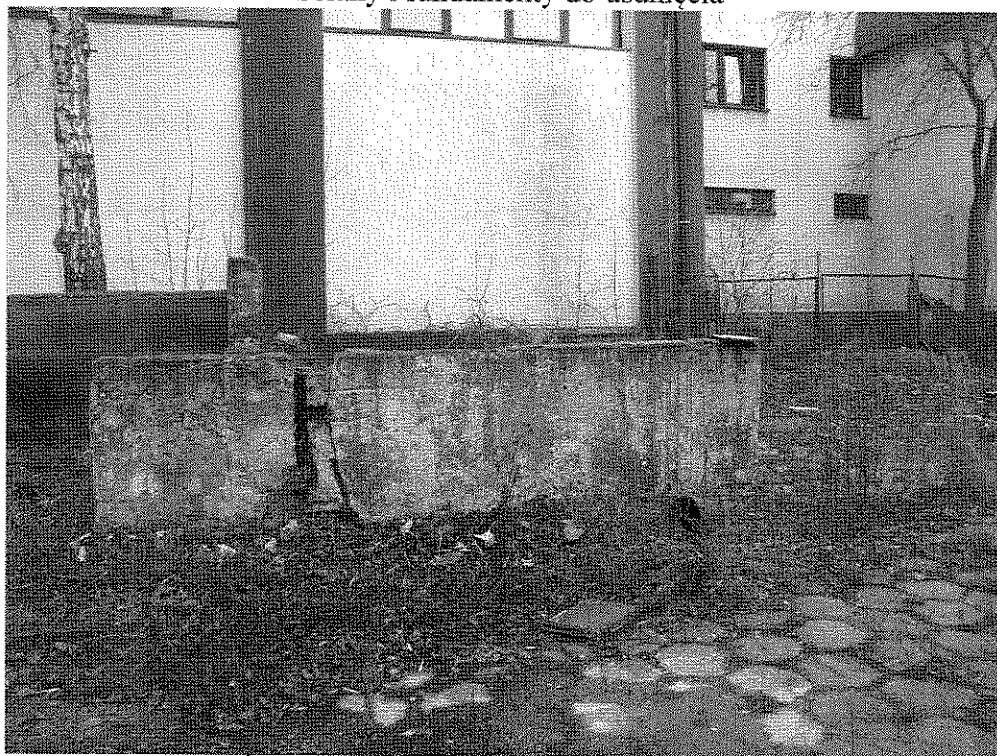
Ściany wraz z fundamentami do usunięcia
