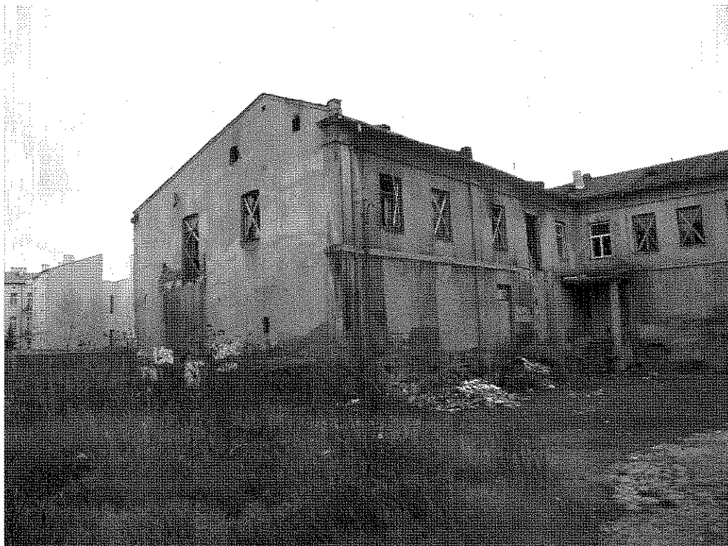
Budynek 2 – do rozbioru
