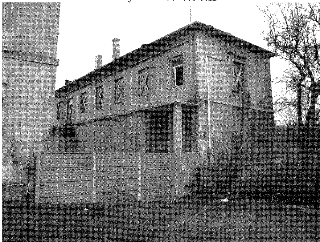
Budynek 2 – do rozbiórki
