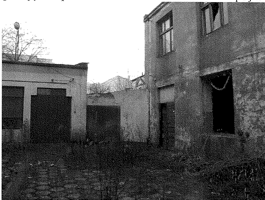
Ściana wraz z bramą do usunięcia
