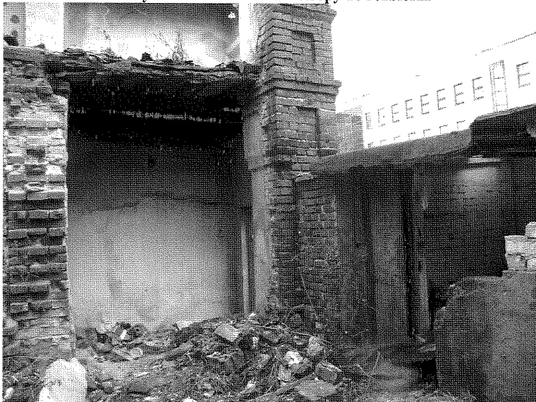
Budynek 5 - dobudówka – do rozbiórki
