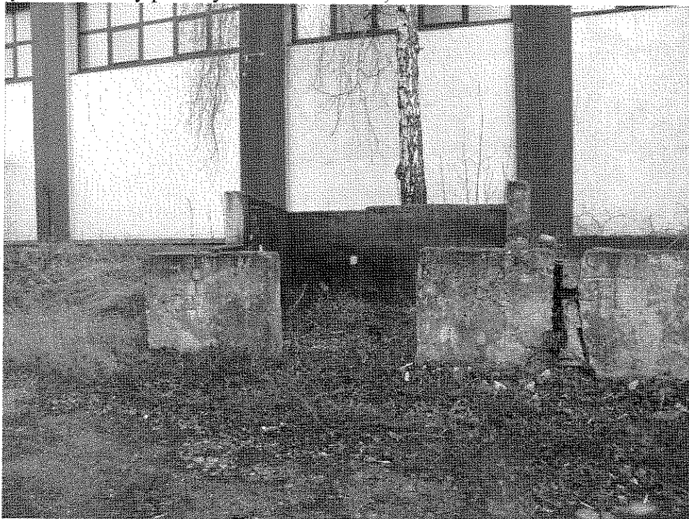
Ściany i fundamenty do usunięcia
