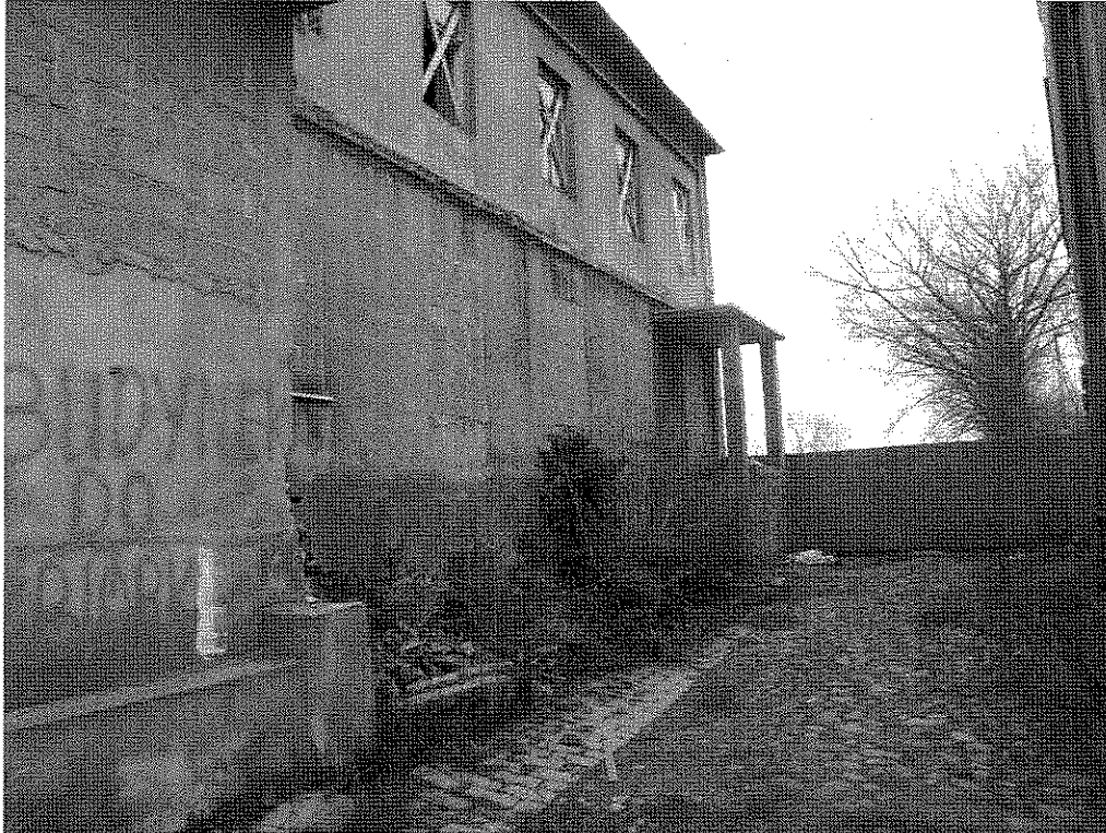
Budynek 2 – do rozbioru
