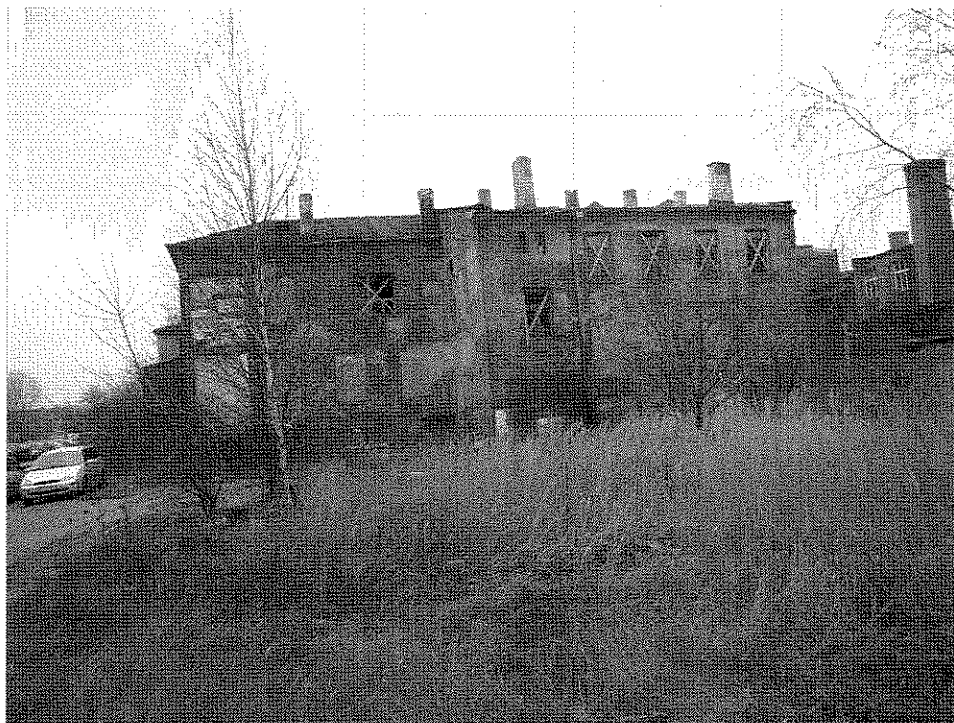
Budynek 2 – do rozbioru
