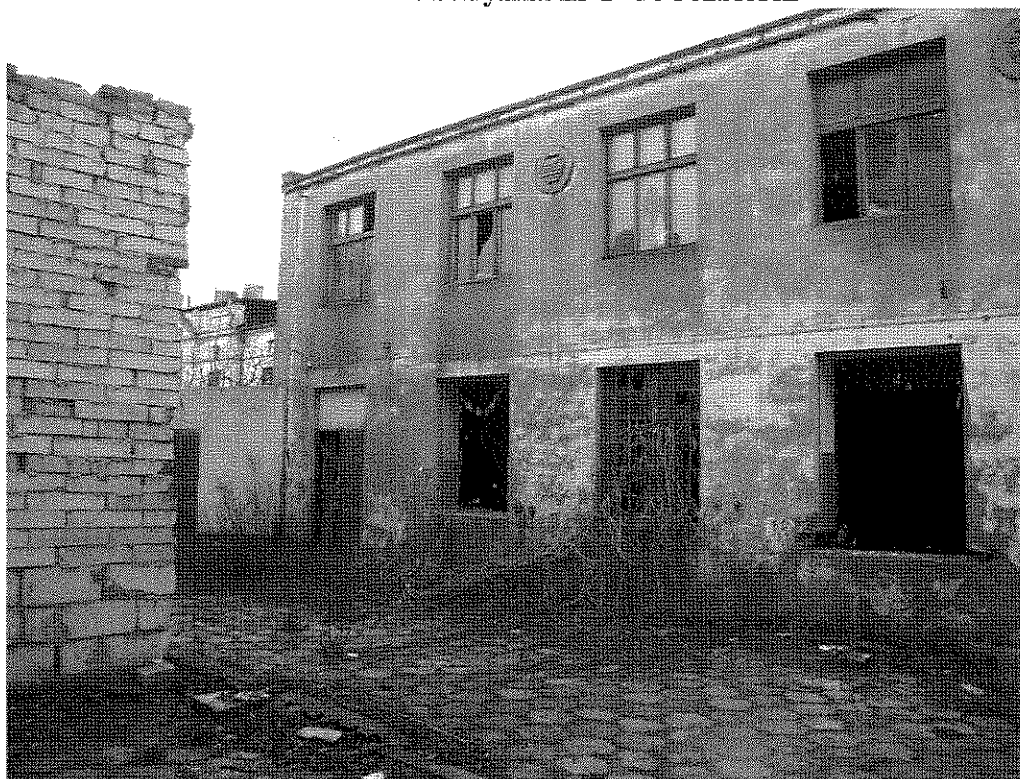
Dobudowana część budynku nr 1 – do rozbiórki
