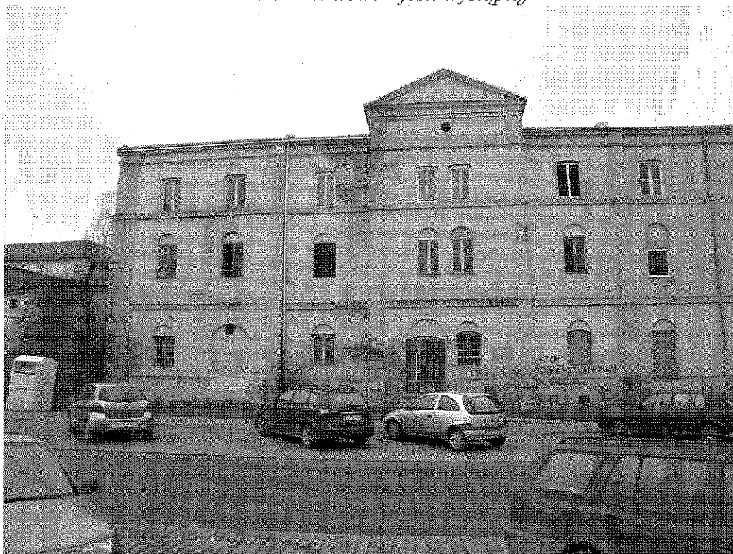
Budynek nr 1 – do rozbiórki
