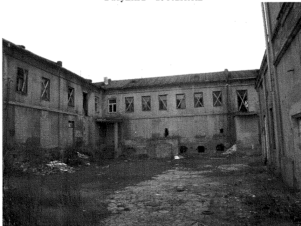
Budynek 2 – do rozbioru
