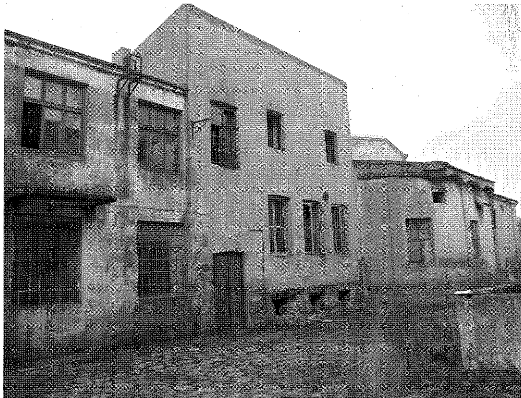
Dobudowana budynku nr 1- do rozbiórki
