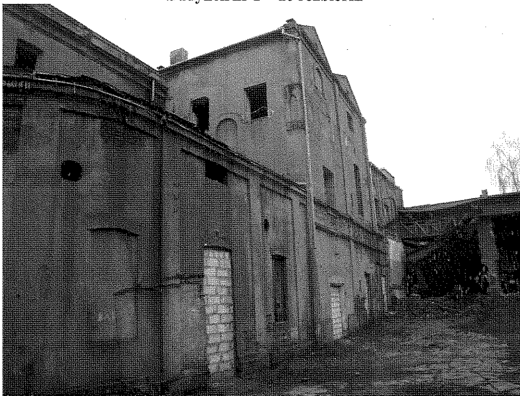
Budynek nr 1 – do rozbiórki
