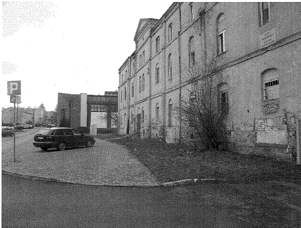
Budynek nr 1 – do rozbiórki
