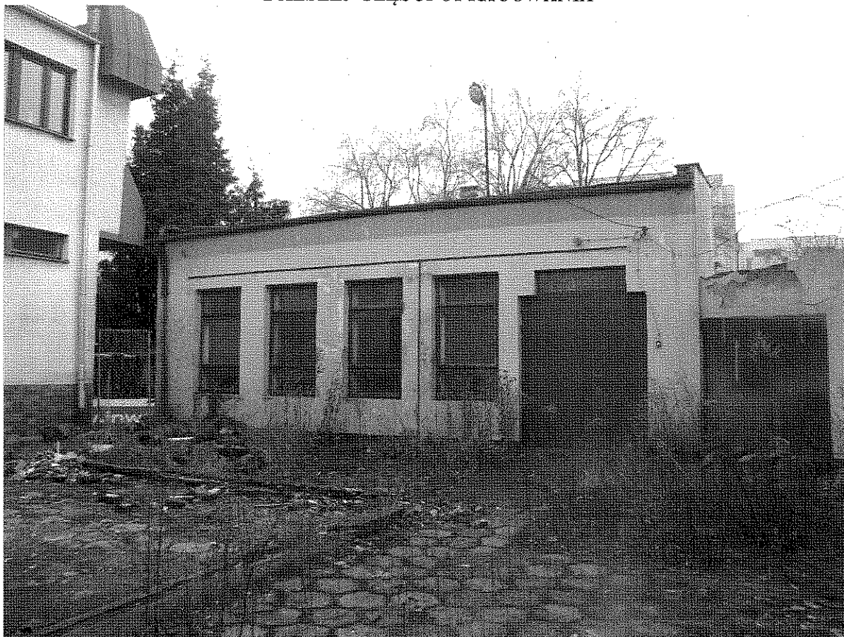
Budynek przemysłowy – do rozbioru
