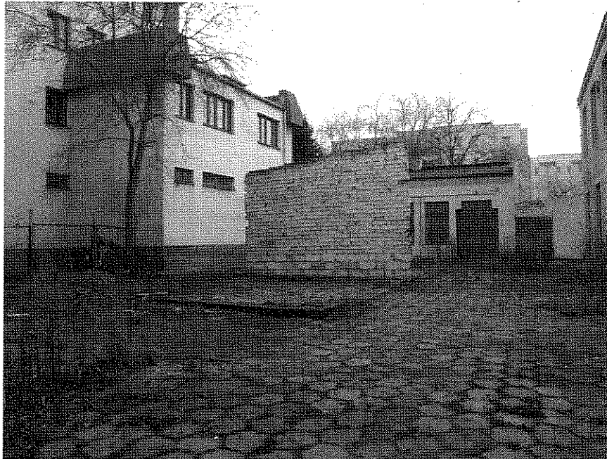
Ściana i fundamenty do usunięcia
