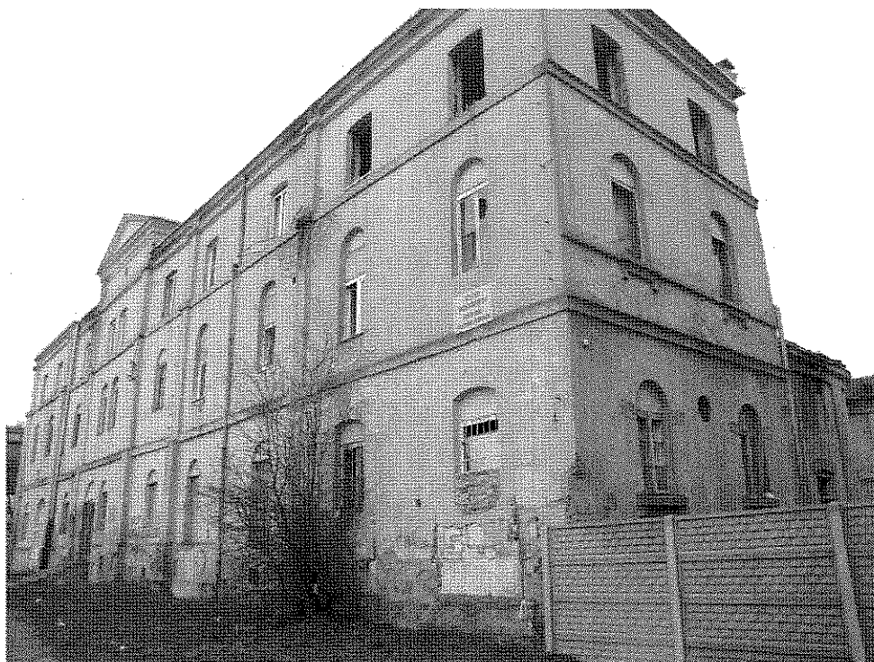
Budynek nr 1 – do rozbiórki
