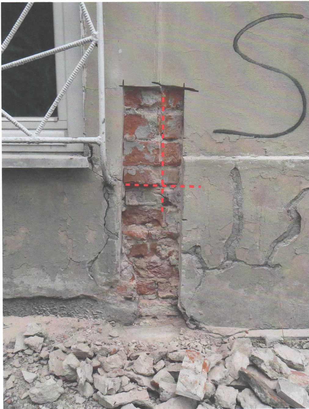
Odkrywka 5- elewacja południowa-opaska okienna okna parteru od strony zachodniej,
