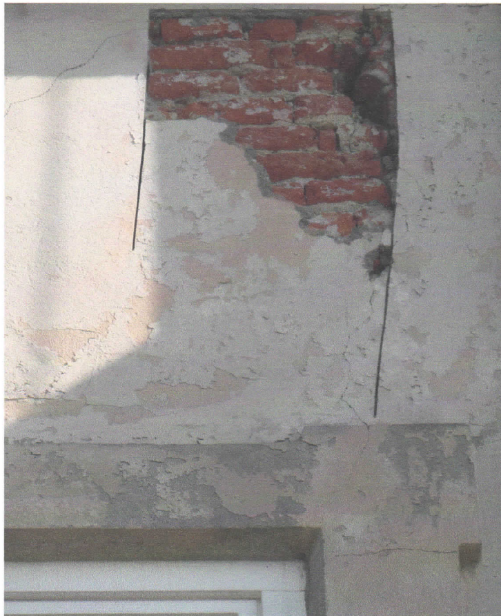
Odkrywka 7- elewacja południowa-nad oknem 1 piętra -strony wschodniej, gdzie mogła istnieć płycina,
