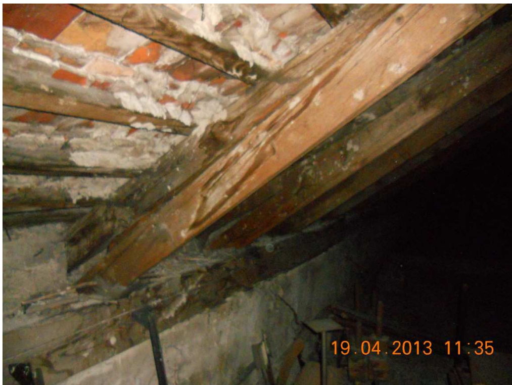
Fot. Nr 4 Krokiew do wymiany na połaci zachodniej budynku szkoły
