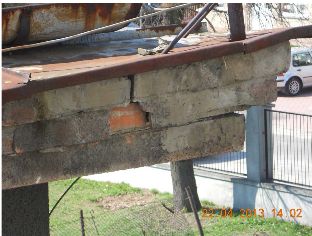
Fot. Nr 2 Zniszczony gzyms w narożniku N-E sali gimnastycznej – konieczne przemurowanie
