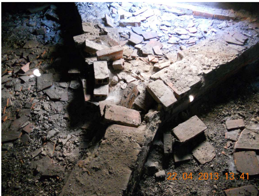
Fot. Nr 11 Poziome kanały wentylacyjne do przemurwania (sala gimnastyczna)
