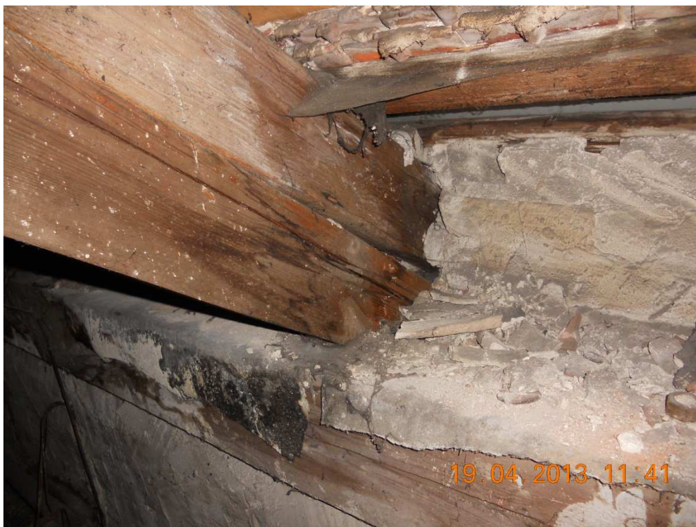
Fot. Nr 7 Krokiew do wymiany na połaci wschodniej budynku szkoły
