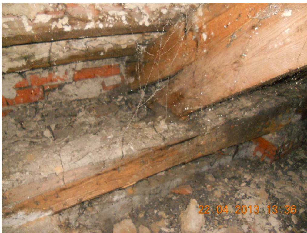
Fot. Nr 10 Zwichrowana murlata do wymiany na połaci północnej i wschodniej sali gimnastycznej
