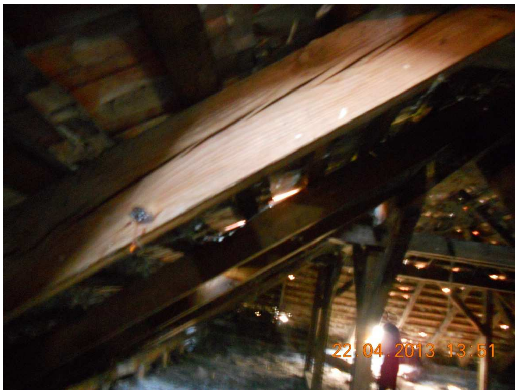
Fot. Nr 9 Krokiew do wymiany na połaci północnej sali gimnastycznej
