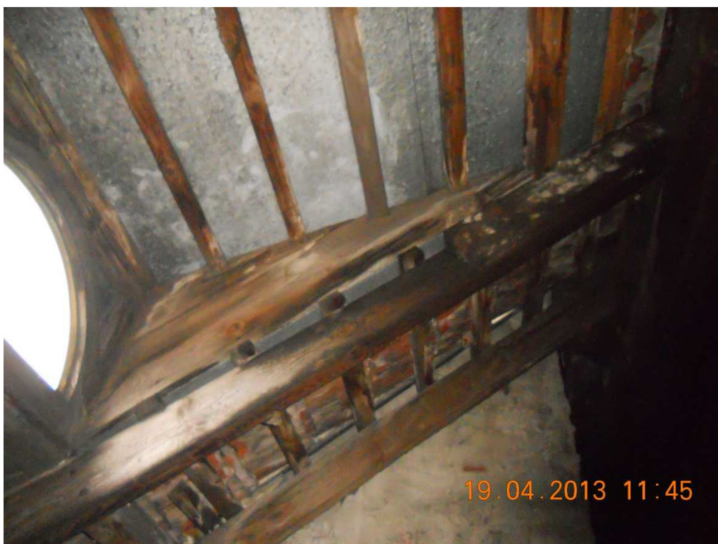
Fot. Nr 8 Krokiew do wymiany na połaci północnej budynku szkoły
