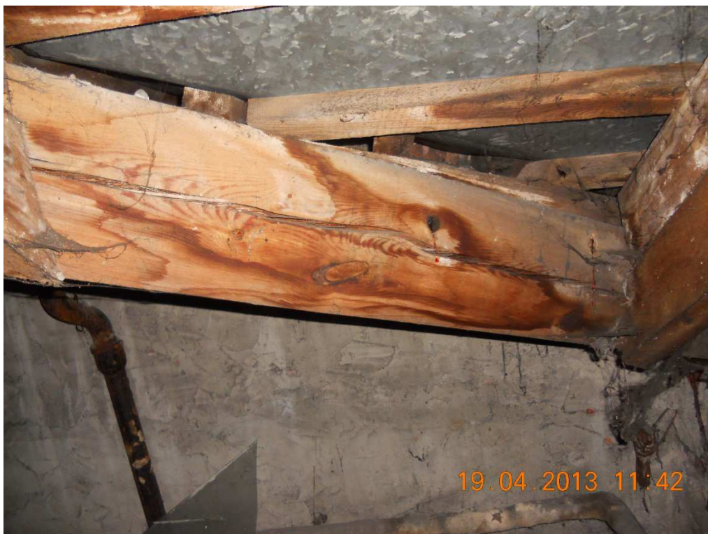
Fot. 3 Krokiew do wymiany na połaci wschodniej budynku szkoły
