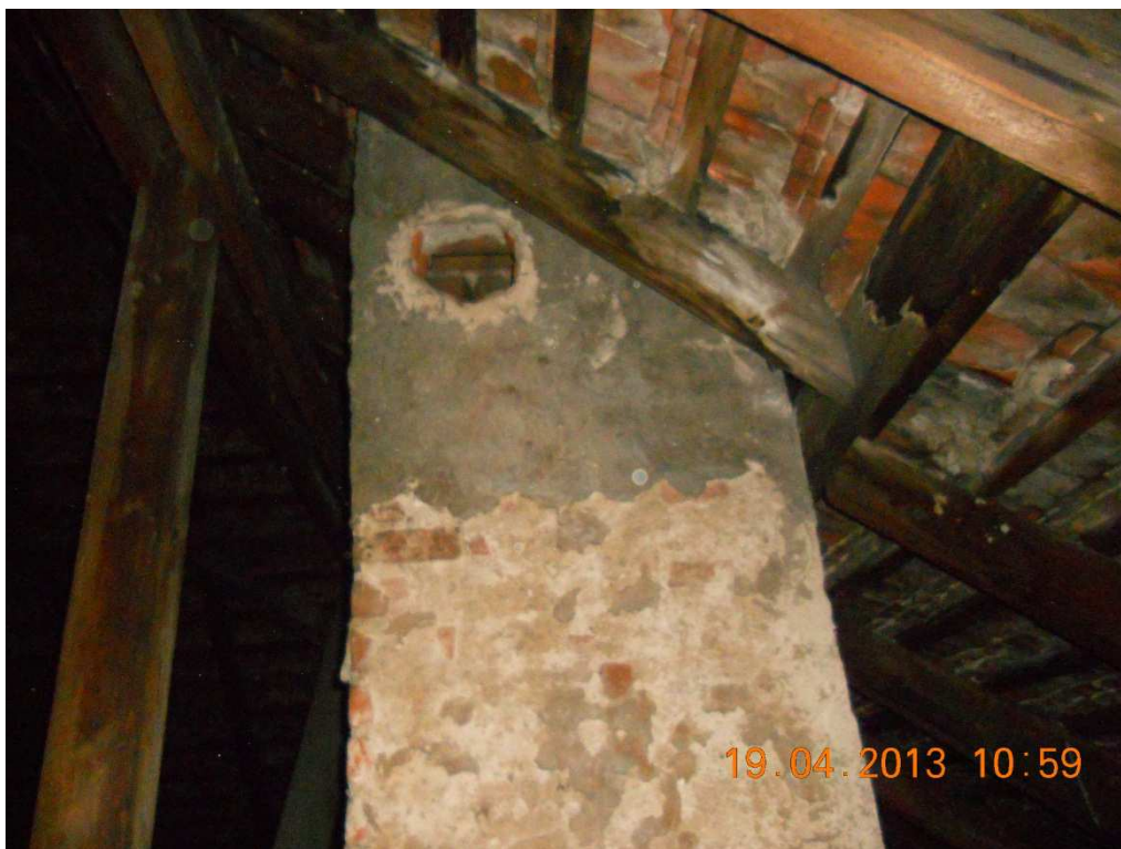
Fot. Nr 6 Krokiew do wymiany przy kominie S-E
