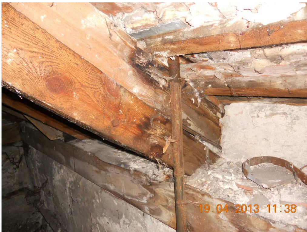
Fot. Nr 5 Krokiew do wymiany na połaci zachodniej budynku szkoły
