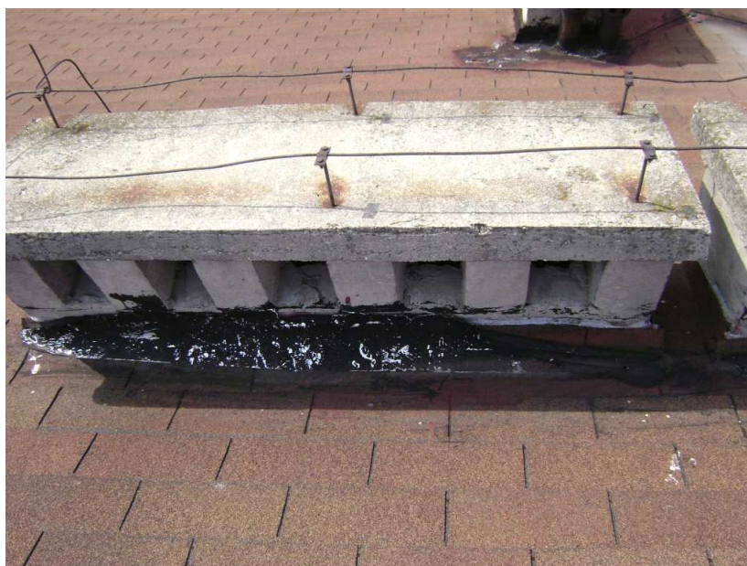
Fot. Obróbka komina
