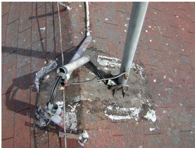
Fot. Obróbka anteny TV
