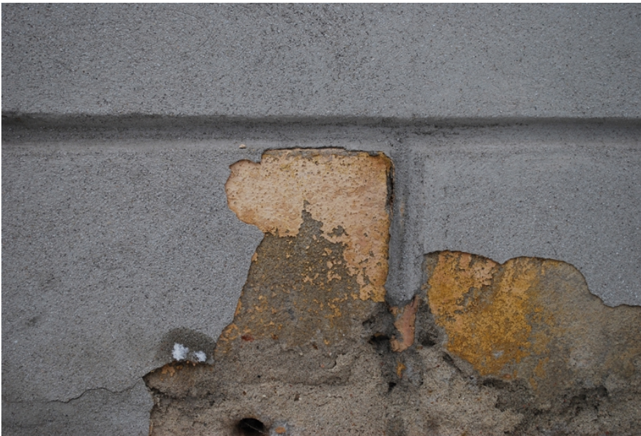
Fot. 1 Układ warstw na elewacji frontowej
