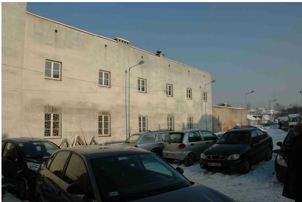
Z.5. Widok na ścianę budynków SPnr8 graniczących z działką – fragment
