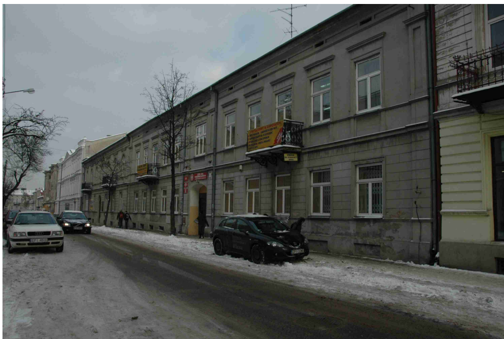
Z.1. Widok na elewację frontową od strony kamienicy południowej nr 12.
