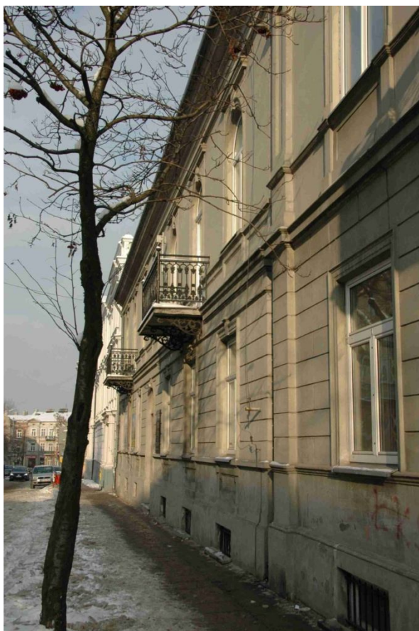
Z.3. Widok na elewację frontową – kamienica północna
