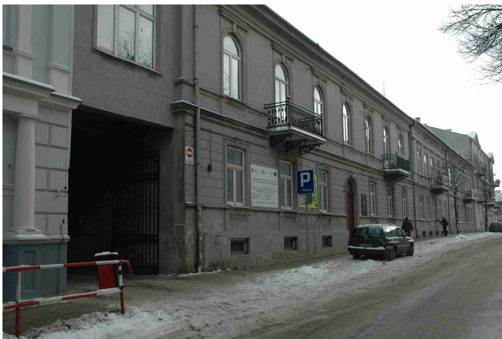
Z.2. Widok na elewację frontową od strony kamienicy północnej nr10.
