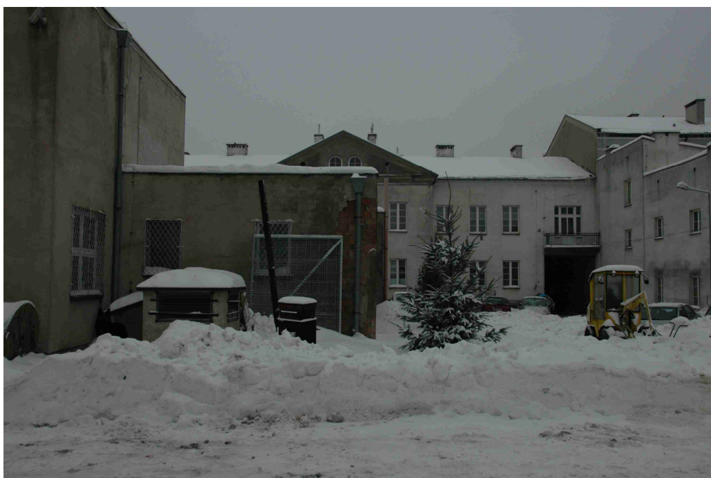
Z.6. Widok na elewację wschodnią kamienicy północnej nr10; ściana budynku SPnr8 granicząca z działką. Fragment budynku w części środkowej – elewacja wschodnia.
