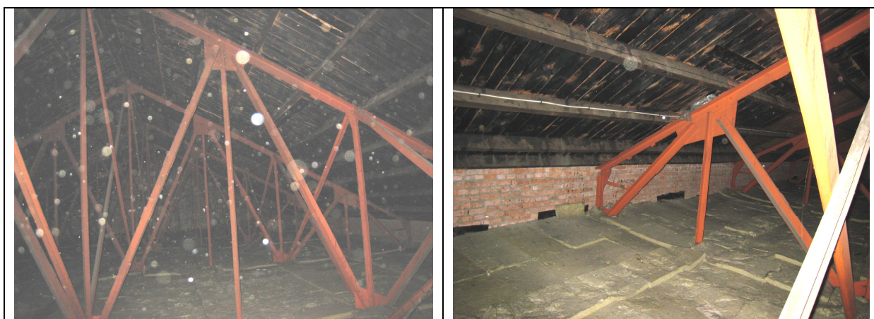
Szkic 4 Kratownice dachowe nad nawą główną.
