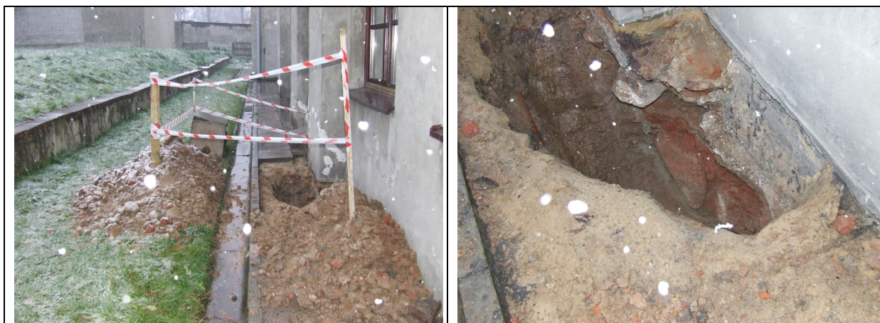
Szkic 7 Odkrywka fundamentu ściany w północno zachodnim narożniku budynku „A”
