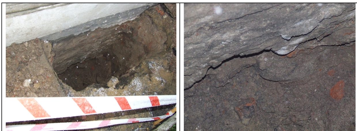
Szkic 6 Odkrywka fundamentu ściany w północno zachodnim narożniku budynku „A”
