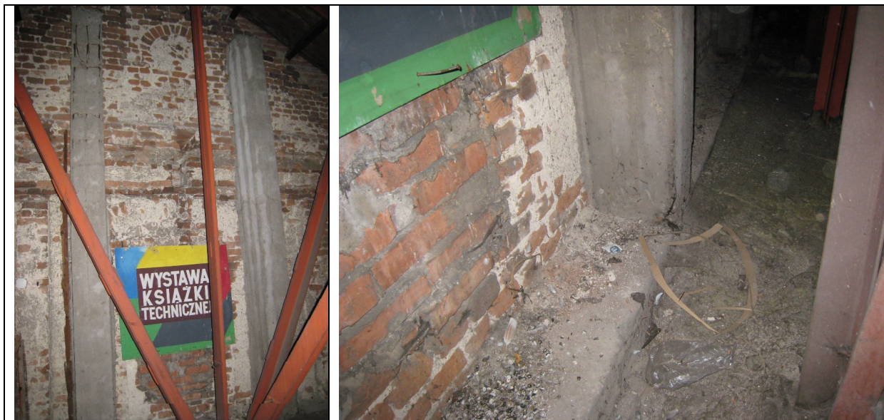
Szkic 5 Wzmocnienie ściany szczytowej wschodniej na poddaszu.
