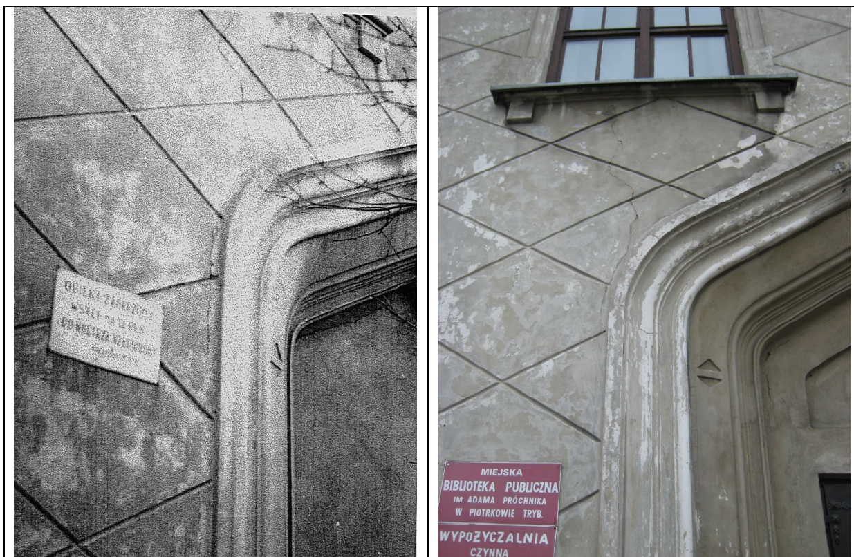
Szkic 12 Stan zachodniej ściany przy głównym wejściu przed i po rekonstrukcji.
