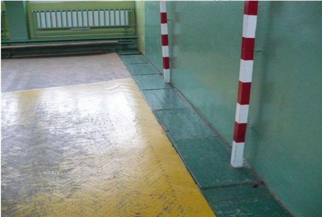
czynny kanał instalacyjny
