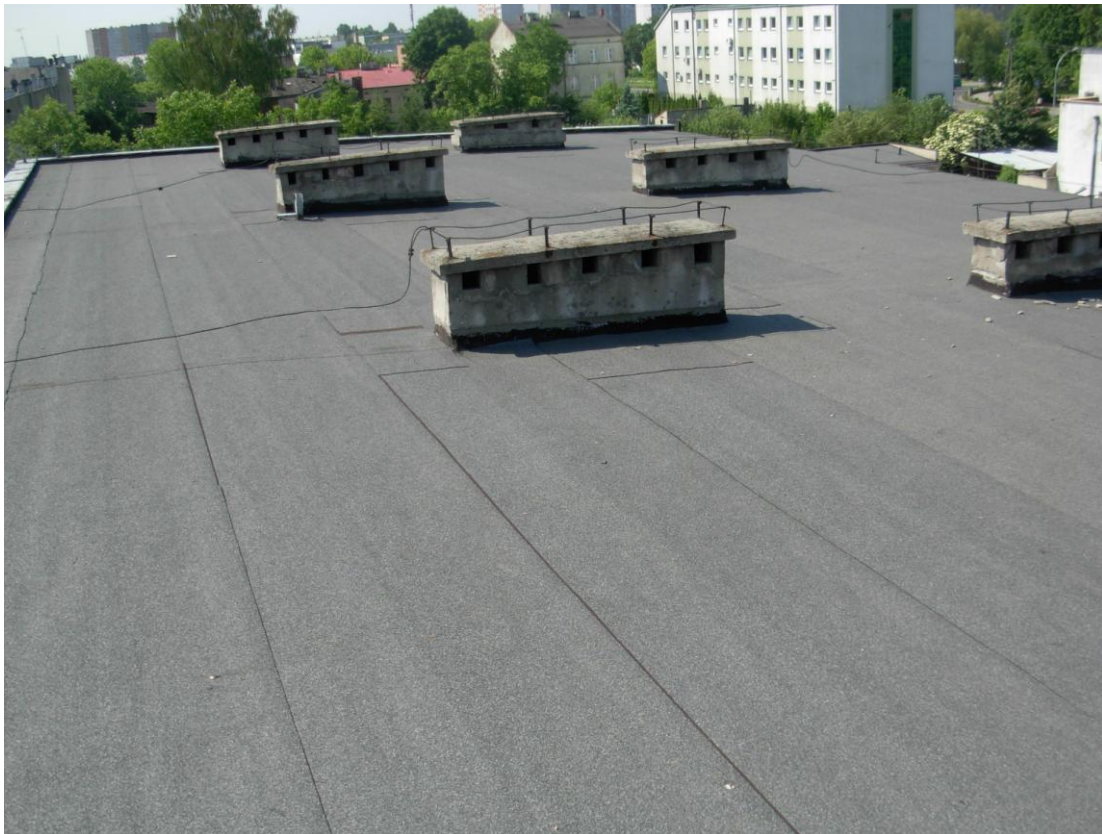
Istniejące podkonstrukcje na dachu do demontażu i fragment instalacji odgromowej do wymiany
