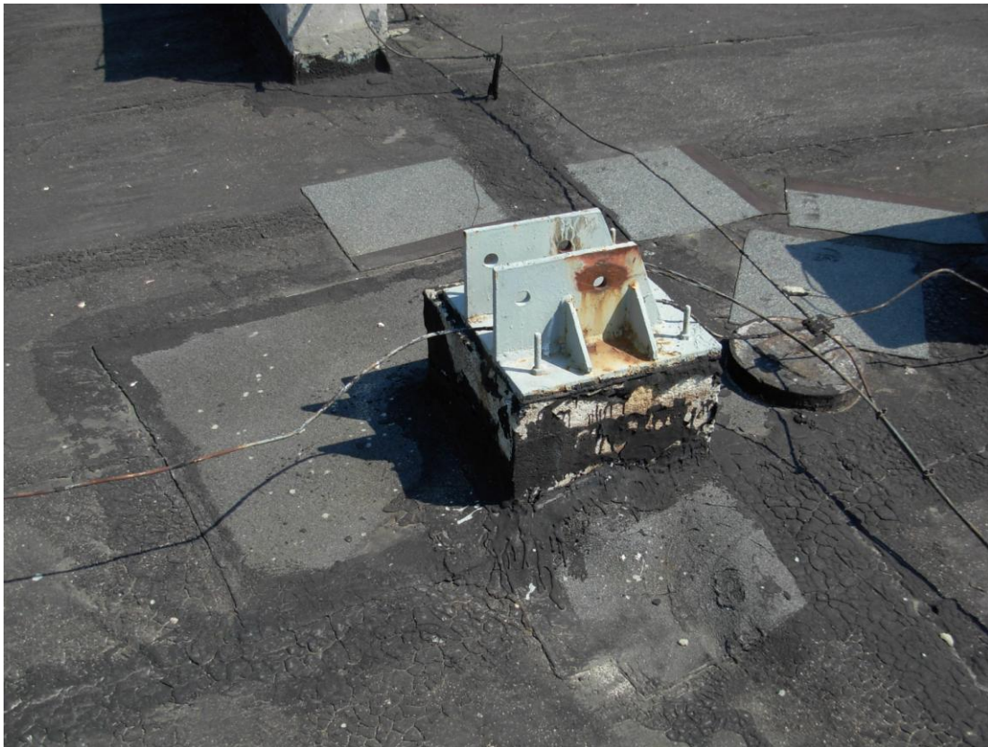
Istniejące podkonstrukcje na dachu do demontażu i fragment instalacji odgromowej do wymiany
