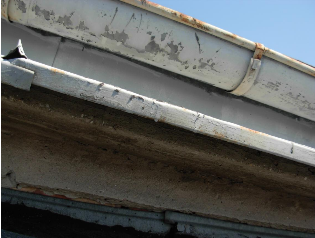
Fragment gzymsu do naprawy, pasa podrynnowego i rynny do wymiany
