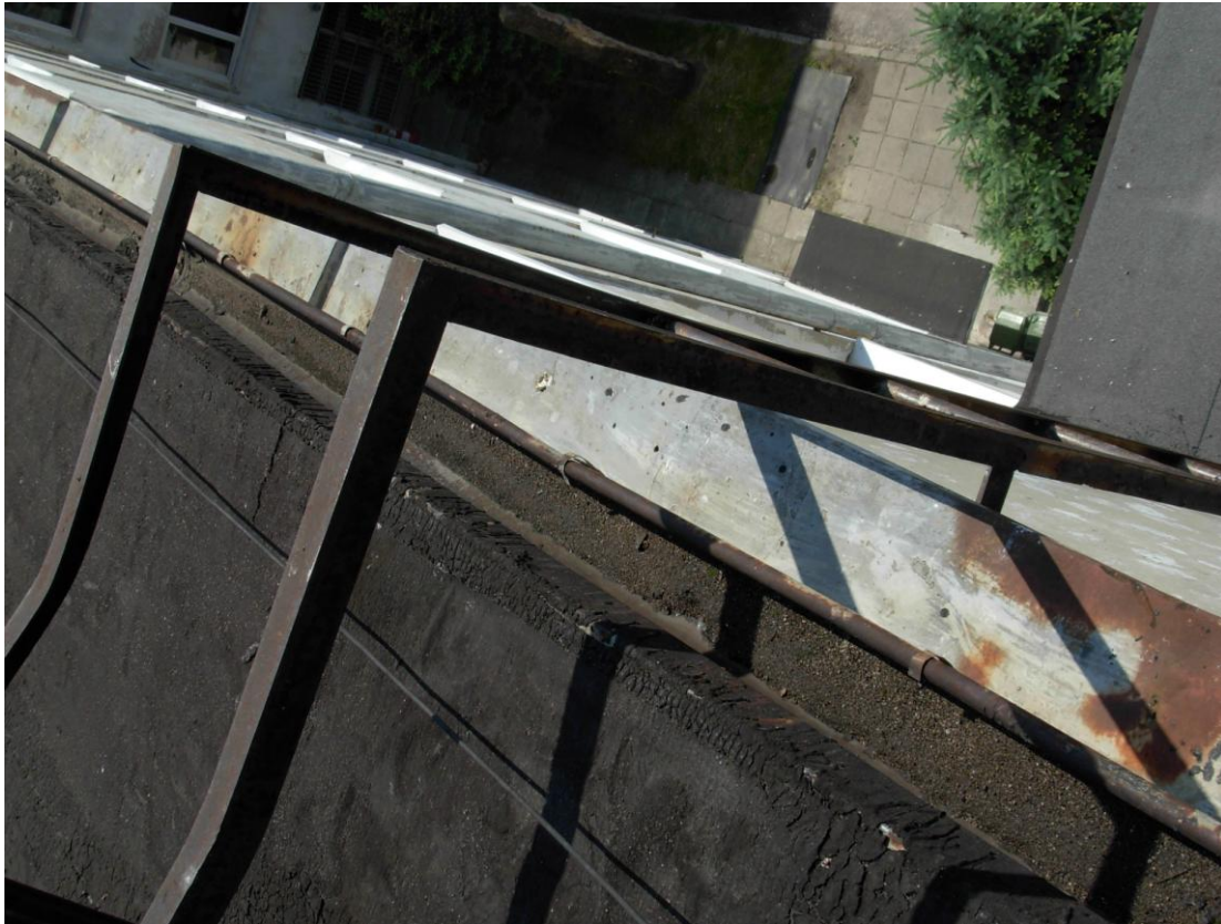
Drabinka zewnętrzna – jeden z elementów zewnętrznych do demontażu, czyszczenia i malowania
