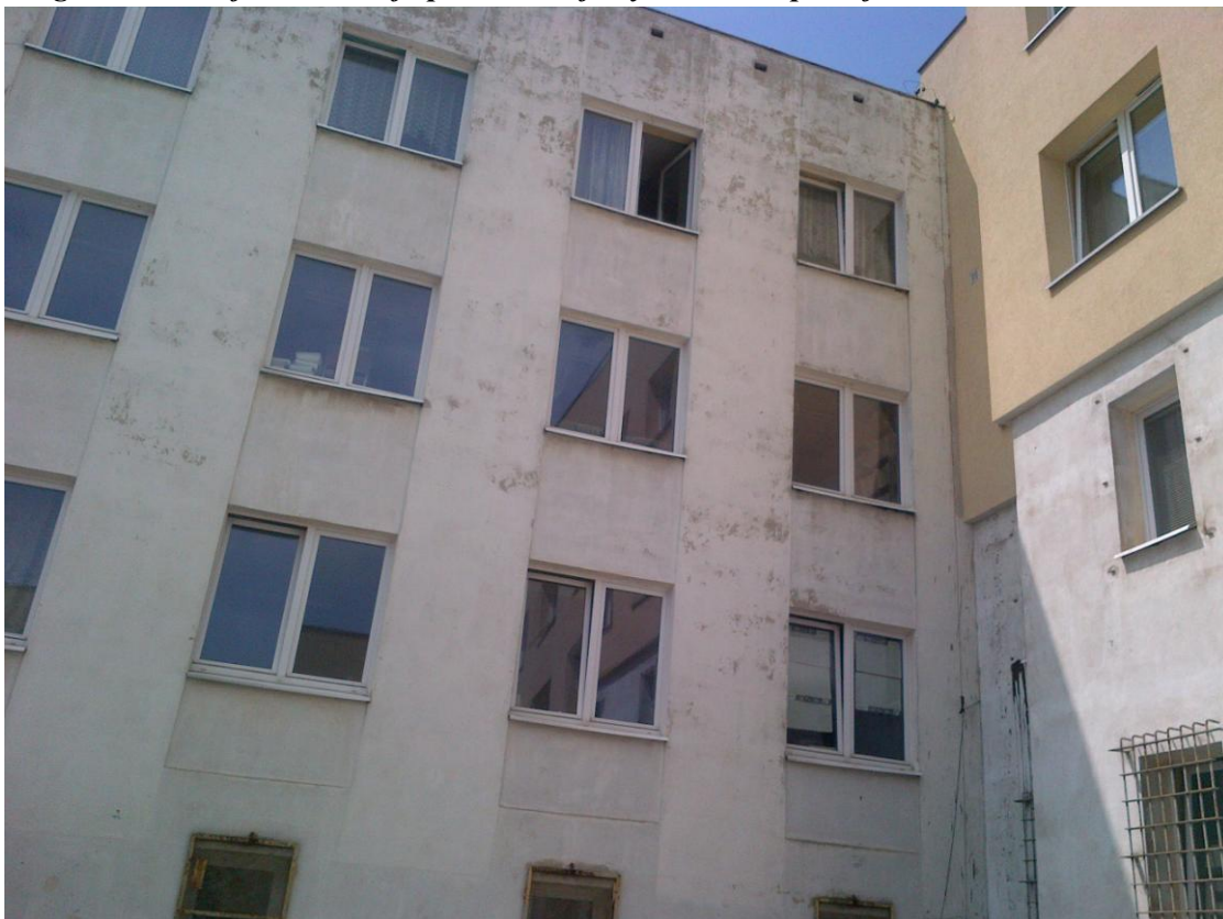
Fragment elewacji zachodniej i południowej częściowo ocieplonej
