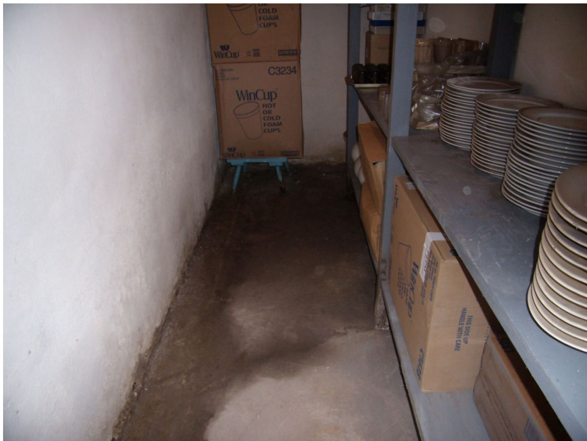
Zawilgocenie podłogi w piwnicy
