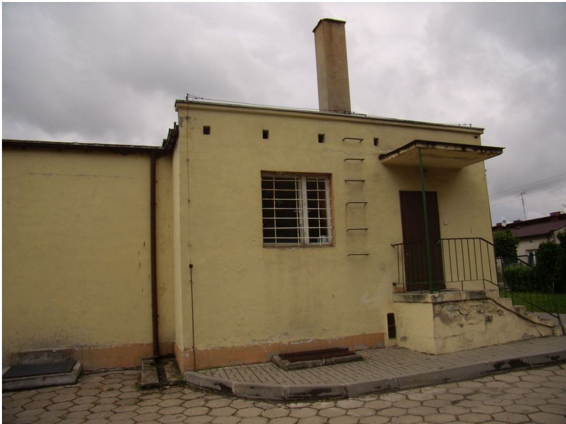
Komin spalinowe i kraty do zsypu węglowego – elewacja zachodnia
