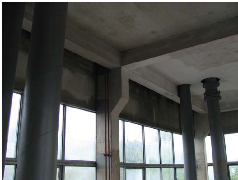
Fot. nr 4 Budynek filtrów – prefabrykowana konstrukcja typu KOLBET
