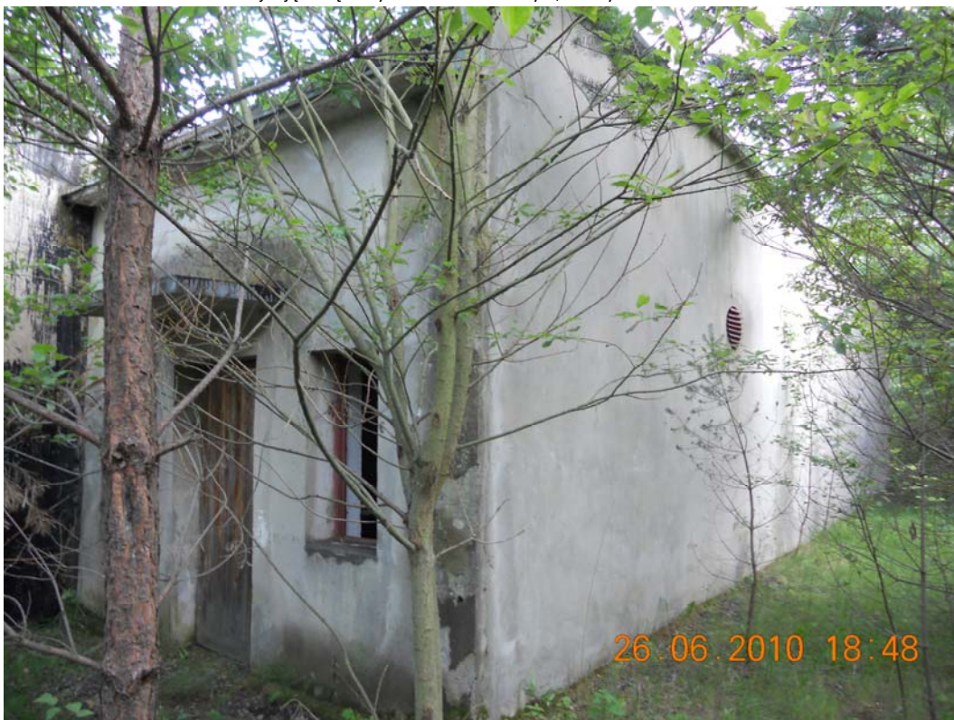
Fot. nr 5 Budynek galerii rurociągów - do zdemontowania obróbki blacharskie, rynna, rury spustowe, wywietrzaki dachowe, stolarka drzwiowa i okienna; wewnątrz budynku należy zasypać gruzem, a otwory okienne i drzwiowe zamurować blokami betonowymi i zatynkować; żelbetowy daszek nad wejściem odciąć, tynki uzupełnić, na wierzchu dachu oraz koronie ściany oporowej widocznej z lewej strony wykonać ogrodzenie zabezpieczające przed upadkiem z wysokości
