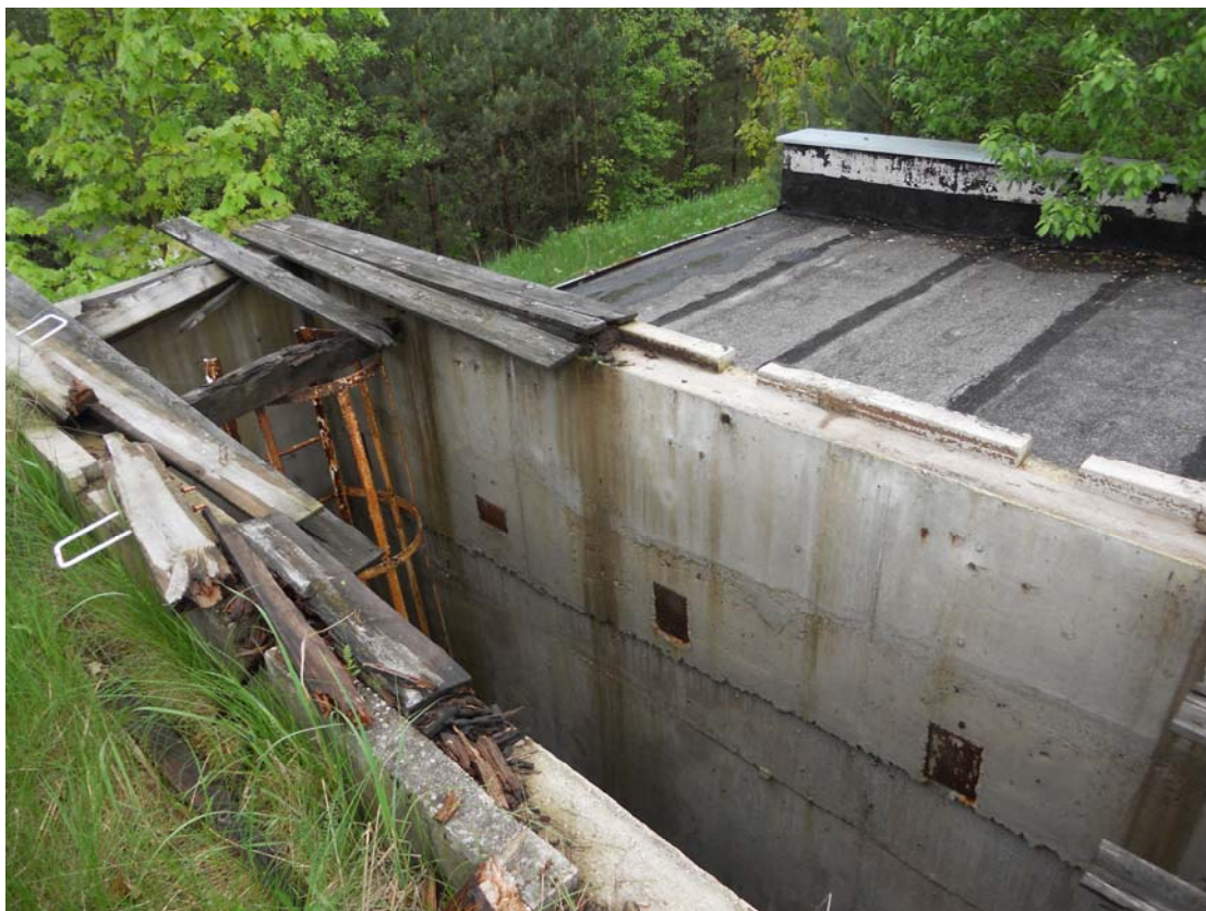
Fot. nr 3 Widok na komorę odstoju wody popłucznych. Którą należy zasypać gruzem, na wierzchu, po zagęszczeniu podłoża należy wykonać żelbetową płytę, następnie wykonać izolację przeciwwodną oraz zasypać ziemią
