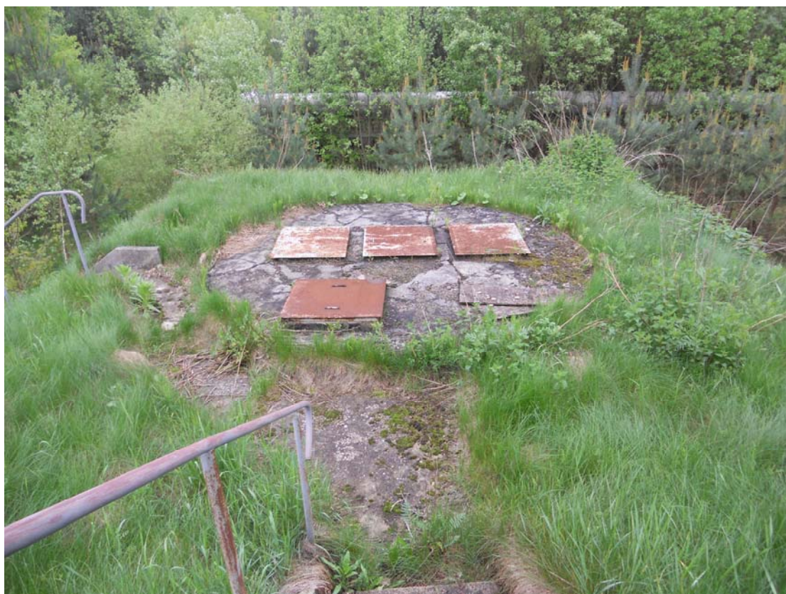
Fot. nr 4 Widok na komorę przepompowni wody popłucznych – po zasypaniu gruzem przez otwory wejściowe, wszystkie otwory należy zabetonować zgodnie z opisem technicznym oraz przysypać ziemią i obsiać trawą
