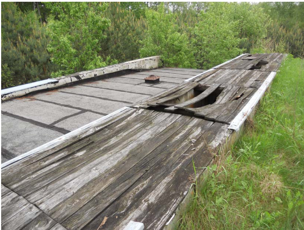
Fot. nr 5 Widok na komorę odstojnika oraz budynek galerii rurociągów – na murze ogniowym oraz ścianach poprzecznych budynku galerii rurociągów należy wykonać ogrodzenie zabezpieczające przed upadkiem z wysokości; widoczne nakrywy zabezpieczające z desek, znajdujące się w złym stanie technicznym, należy zdemontować
