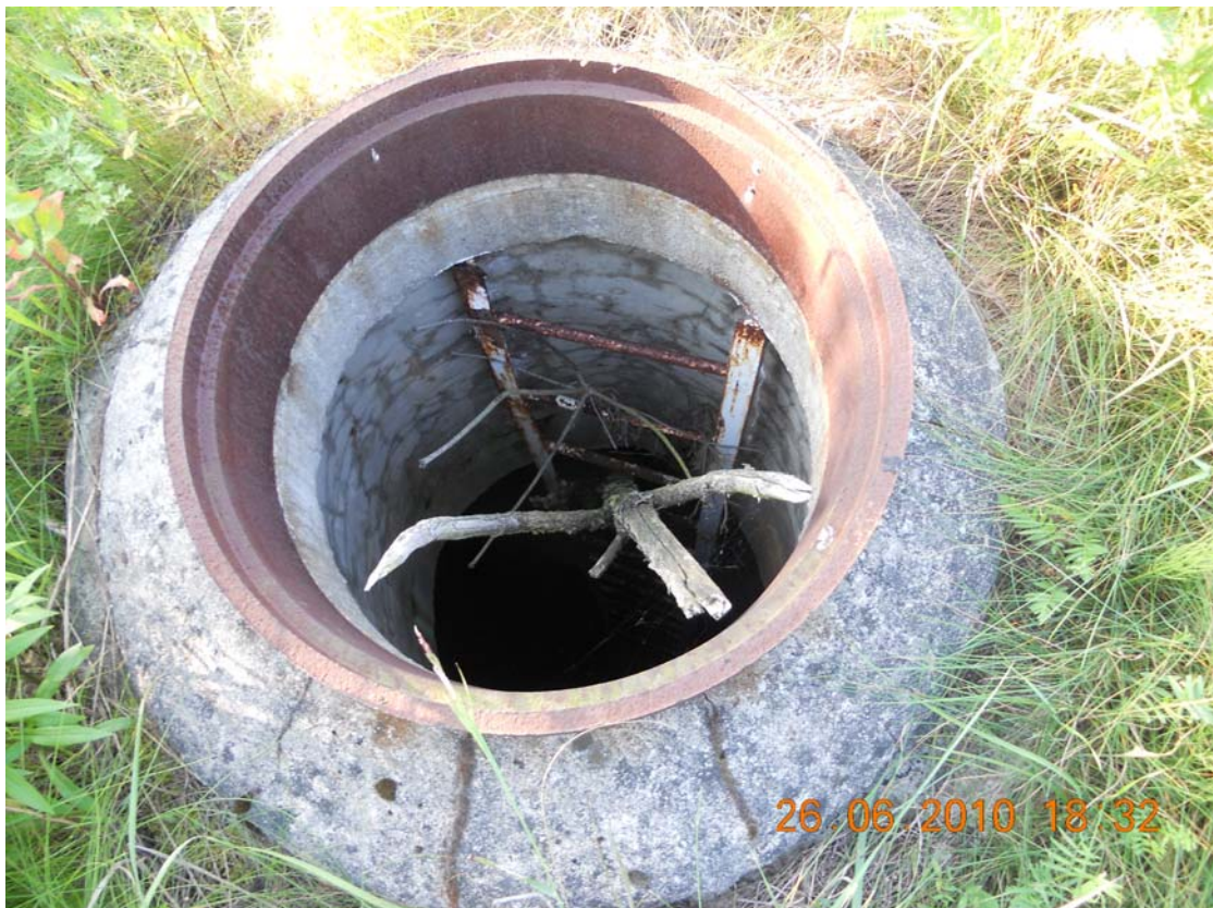
Fot. nr 8 Studzienka wejściowa do odстойnika wód popłucznych – należy rozebrać do poziomego stropu, a po zasypaniu odстойnika gruzem zabetonować zgodnie z opisem technicznym
