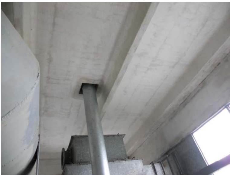
Fot. nr 25 Żelbetowe płyty panwiowe na dachu budynku filtrów
