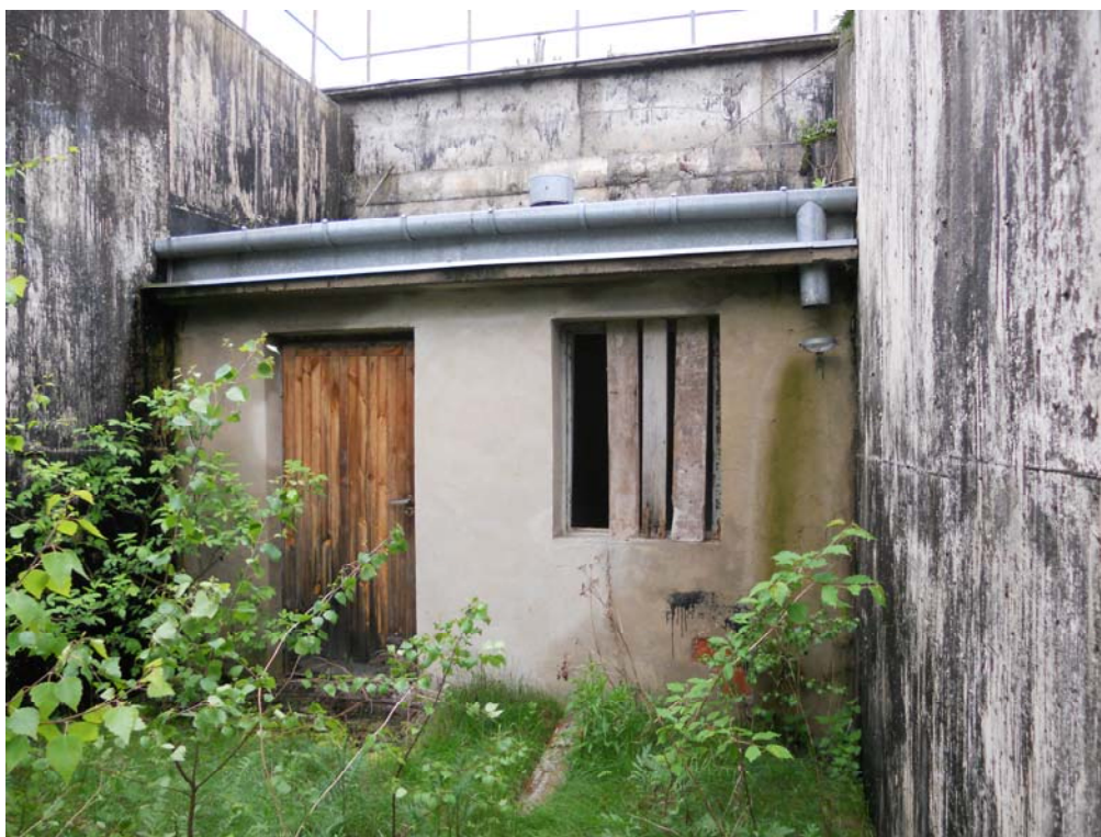
Fot. nr 1 Budynek komory zasuw odstoju wody popłucznych - do zdemontowania obróbki blacharskie, rynna, sztucer rury spustowej, wentylator dachowy, stolarka drzwiowa i okienna; wewnątrz komory należy zasypać gruzem, a otwory okienne i drzwiowe zamurować blokami betonowymi i zatynkować; następnie widoczne po obu stronach komory ściany oporowe wraz ze ścianą komory zaizolować i zasypać ziemią wykonując skarpe nasypu; w ostatniej kolejności nasyp obsypać humusem i obsiać trawą
