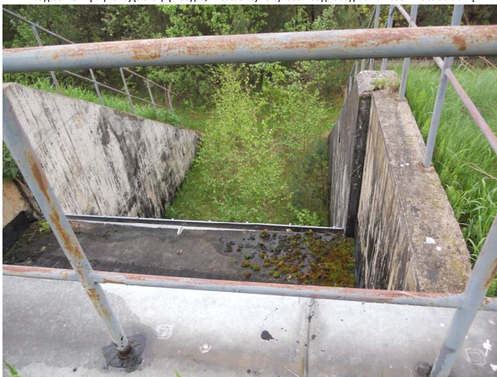
Fot. nr 2 Budynek komory zasuw widziany z góry, po bokach widoczne skarpy nasypu; w analogiczny sposób należy ukształtować skarpe pomiędzy ścianami oporowymi; po ukształtowaniu skarpy można będzie zdemontować stalową balustradę
